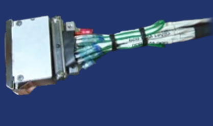
熱収縮スリーブ施工一例
